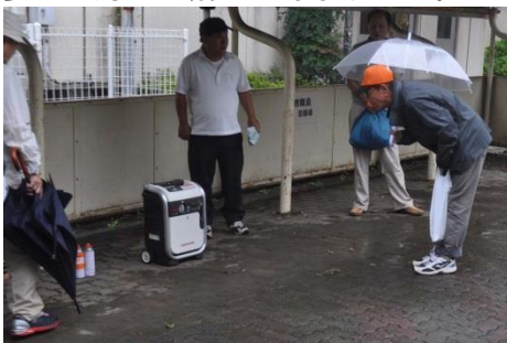
防災用具庫には発電機も(上山口中)
