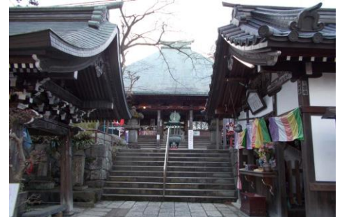
元弘3年(1333)に新田義貞が寄贈した 霊馬堂(右)。(昭和11年に改修)
