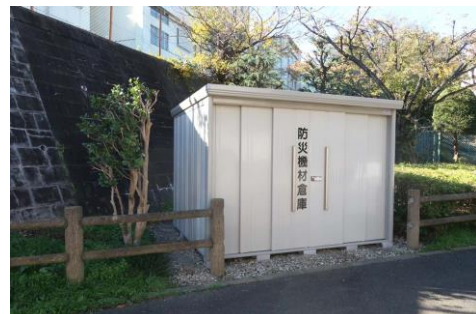
町内会の防災倉庫も新設されました。
